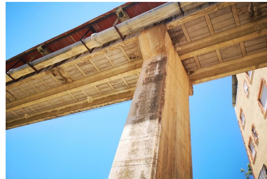
Proyecto de rehabilitación Pasarela Peatonal, Reposición hormigón y armados en el lecho del Río Cárnoles (Moixent) [Valencia].
